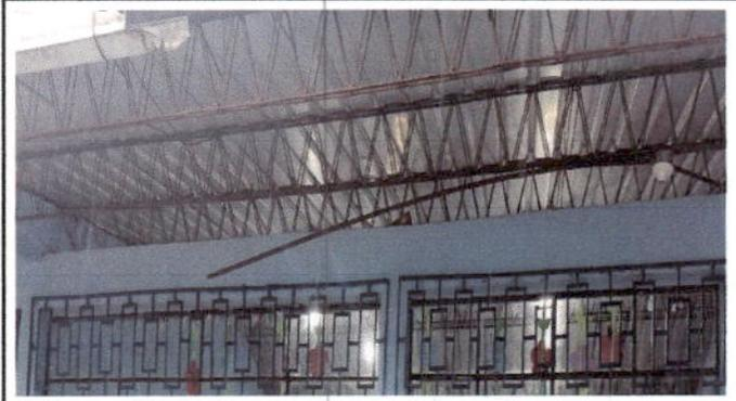
Foto 2 Sustitución de soportes por costaneras galvanizadas.
